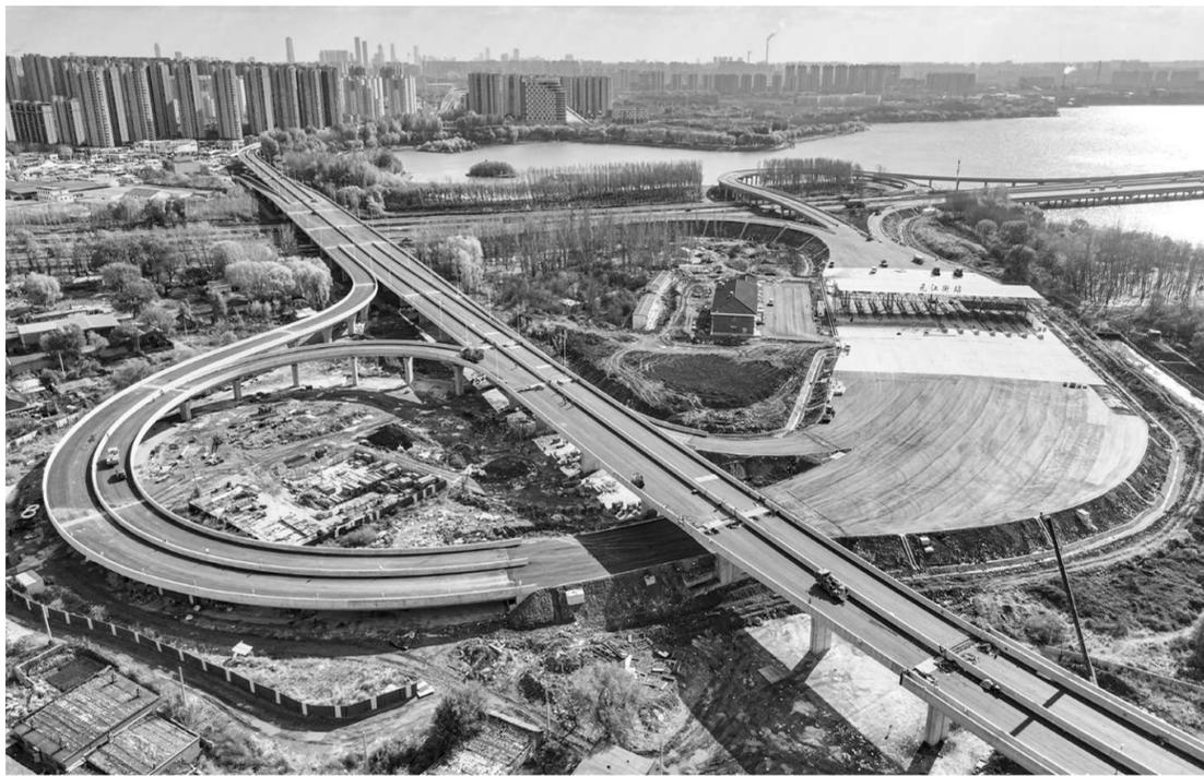
11月4日，元江街快速路工程进入收尾阶段。据了解，沈阳元江街快速路工程位于沈阳市于洪区，主线桥南起白山路南侧，北至于虎铁路北侧与沈马公路衔接，沿线走行现状元江街，高架桥全长3868米。元江街快速路桥梁由南向北分别跨越白山路、锦山路、松山西路、橙山路、赤山路、三环绕城高速、于虎铁路后落地。 张文魁摄
